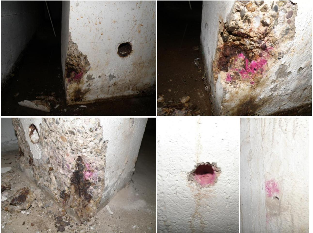
Bilder 5.15 bis 5.19: Beispiele Karbonatisierungstiefenbestimmung
