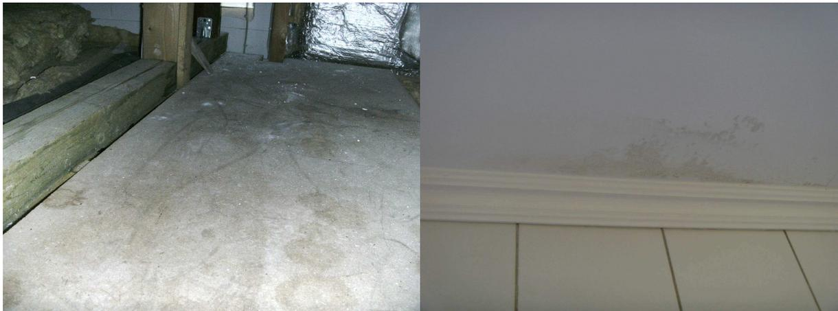
Abb. 1 + 2: Tauwasserschäden auf der Schalung im Kaldachraum sowie am Innenputz in der Raumecke
