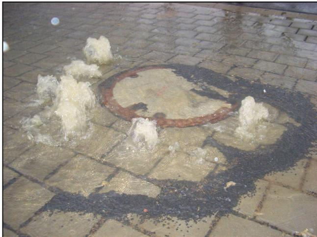
Abb. 5-3: Schacht mit druckdichtem Deckel im Januar 2011, Ortsteil Bach
