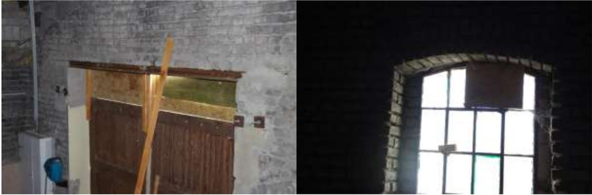
**Abbildung 9:** Geschlossene Öffnung im Nordbereich mit Holzverkleidung. Links über dem Tor und rechts das Fenster.
