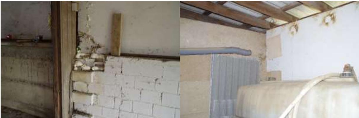
**Abbildung 4:** Geschlossene Öffnungen innerhalb der östlichen Wand der Reithalle.
