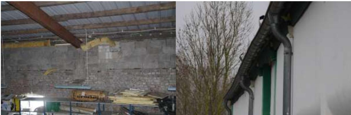
**Abbildung 10:** Mit Materialwolle abgedichtete Öffnungen entlang des Daches im Westbereich des Hofgebäudes. Links: Innen, Rechts: Außen.
