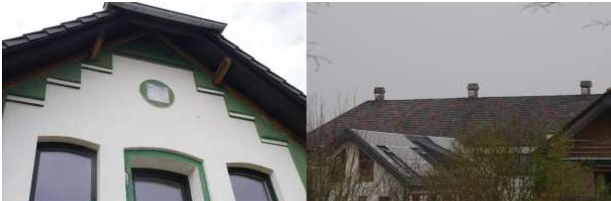
**Abbildung 6:** Links: Mit Metallgitter abgedichtetes Loch zu den ehemaligen Wohnungen. Rechts: Mit Metallgitter abgedichtete Öffnungen der Kamine.
