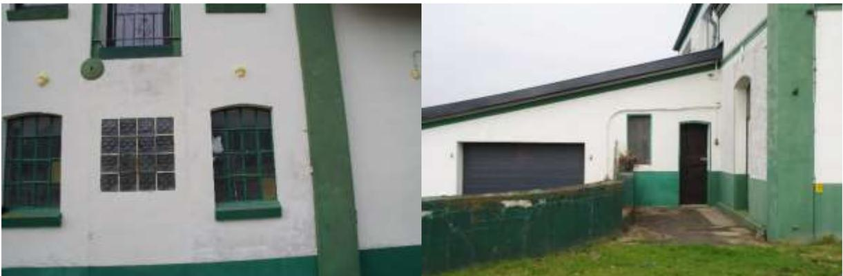
**Abbildung 7:** Links: Mit Bauschaum ausgeschäumte Löcher der Ostwand des Hofgebäudes und abgeklebte Öffnung im Fenster. Rechts: Mit Holzverkleidung geschlossenes Fenster im Südbereich.
