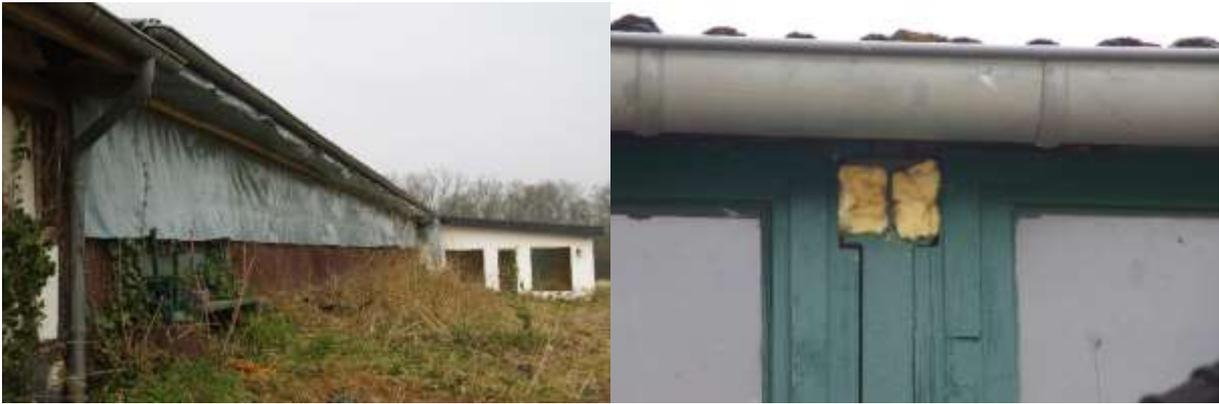
**Abbildung 3:** Links: Folienabdeckung der Öffnungen entlang des Dachverlaufes der Reithalle (östliche Wand). Rechts: Materialwolle als Abdichtung der Öffnungen an den Verstrebungen entlang des Dachverlaufes der Reithalle (westliche Wand).
