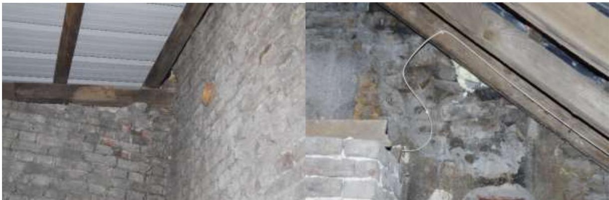
**Abbildung 8:** Mit Bauschaum ausgeschäumte Löcher in Wand-Decken-Kanten im Nordbereich (links) und Südbereich (rechts).
